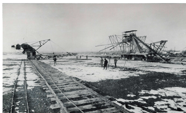
Escavatrice in azione per le opere dell'Idroscalo
