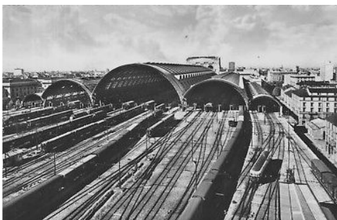
L'inconfondibile tettoia metallica sopra i binari della Stazione Centrale di Milano
