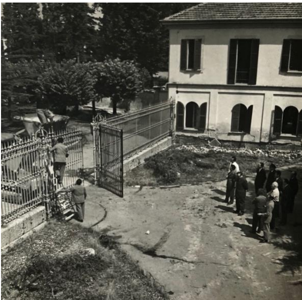
Abbattimento del cancello di ingresso
