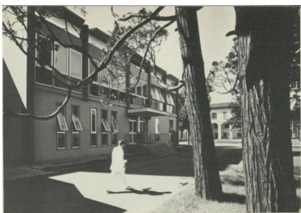
Esterno del complesso ospedaliero Ugo Cerletti
