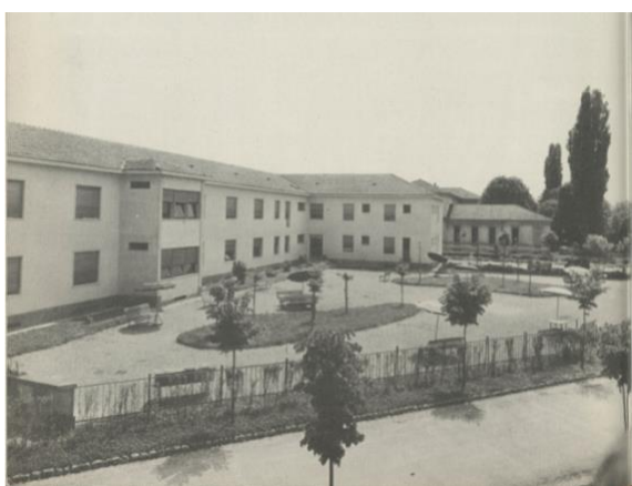
Cortile del nuovo reparto degenza uomini presso l'O.P. Paolo Pini. Costruito insieme ad un reparto uguale per donne nel 1958-59, sarà adibito a osservazione e cura a partire dagli anni Sessanta
