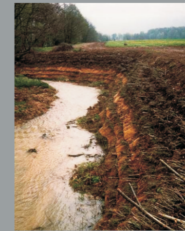
Esempio di gradonata viva. Durante i lavori e situazione finale
