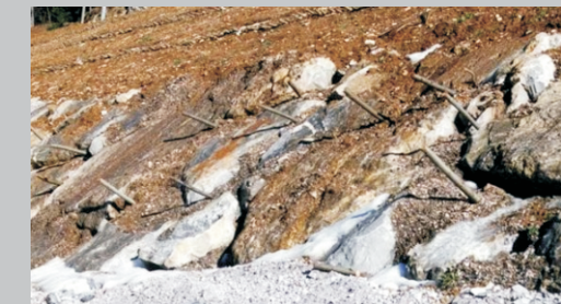
A lavori appena eseguiti
