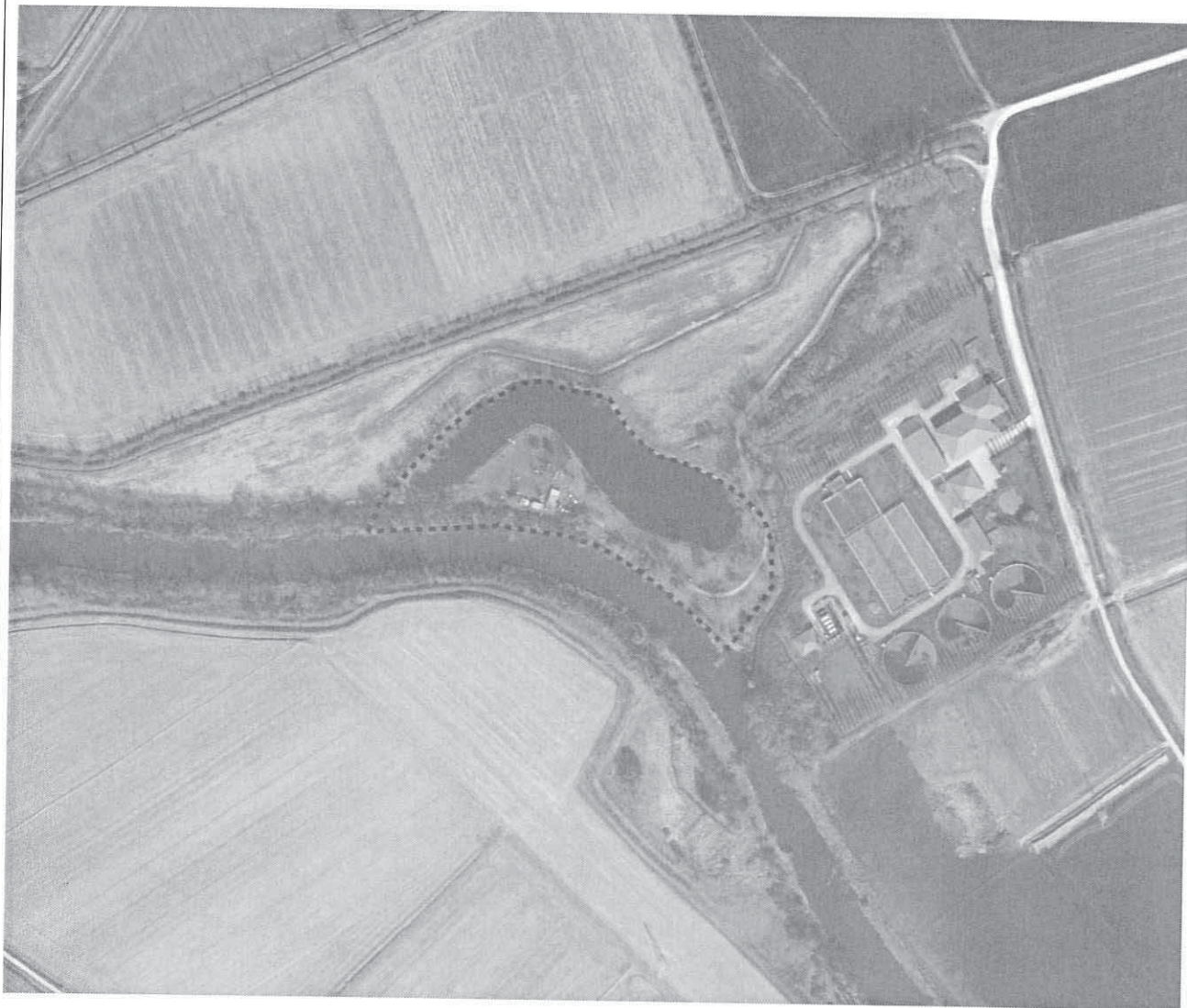
Scheda 3a - Foto aerea dell'ambito d'intervento
